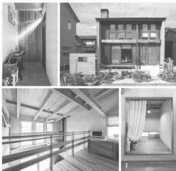
1: 外観。軒と袖壁に囲まれた南側のみ板張り、ほかはガルバリウムスパンダレルZIG張り。掃き出し窓は可動ルーバー式の雨戸付き。 2: 玄関は蓄熱土間から同じタイルで続く。板張りの壁の奥は収納。 3: 板張りの小上がりはお母さんの寝室にも。4: 階段を上ったフリースペースには、ホームライブラリーコーナーも。梁にはステンレスパイプをつけて洗濯物の部屋干しに活用。
